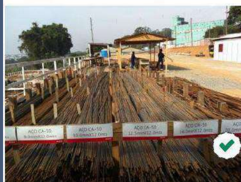
Armazenamento separado por bitola e identificado
