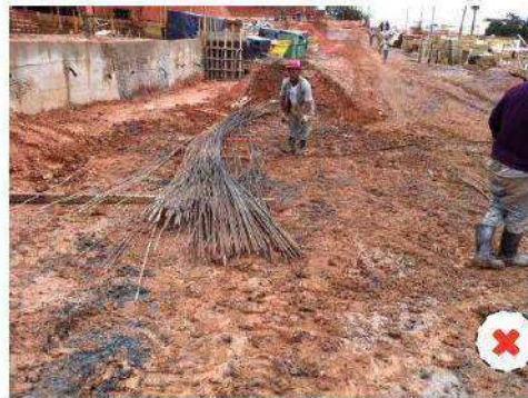
Aço em contato direto com o solo
