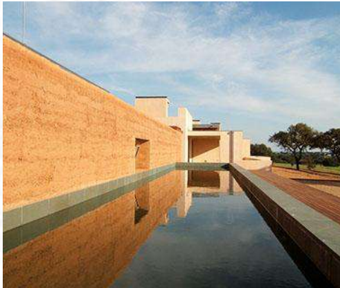
Construção em terra betaoetaipa.pt Alentejo, Portugal
