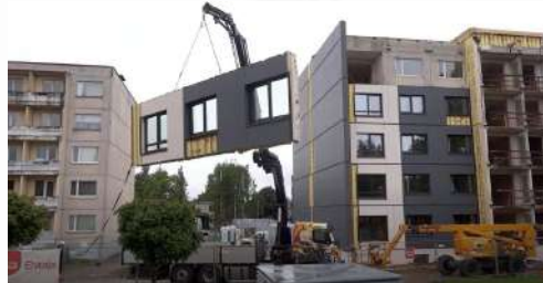
Fachada integrada com sistemas de ventilação e condutas técnicas Fonte: More-Connect
